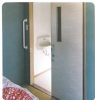
高齢者寝室も押し入れをトイレに変更
